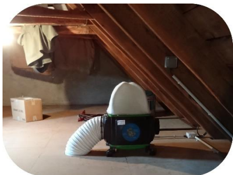
Vue après travaux : drain et SDS installés, enduit façade refait
