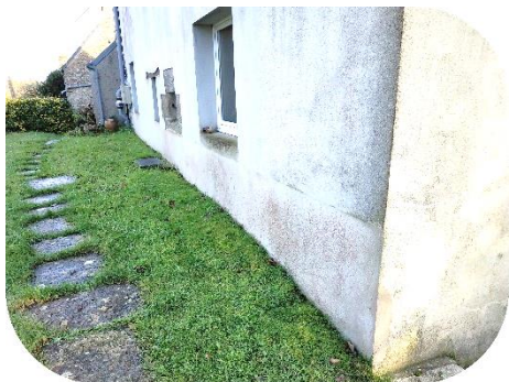
Vue après travaux : drain et SDS installés, enduit façade refait
